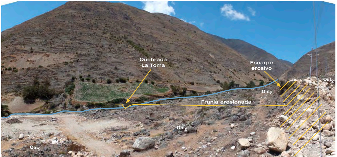
Fig. 4.33. Surco y escarpe erosivo en la zona proximal del abanico. FOTOGRAFÍA TOMADA POR R. AYALA, 2019
