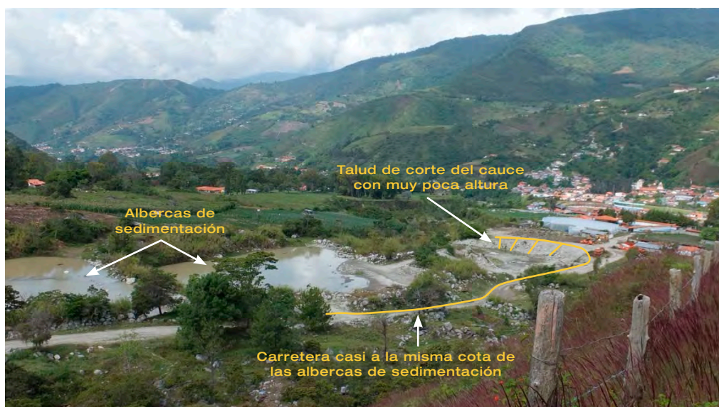
Fig. 4.41. Albercas de sedimentación localizadas luego de la confluencia de las quebradas de La Mucuy y Ño León.
