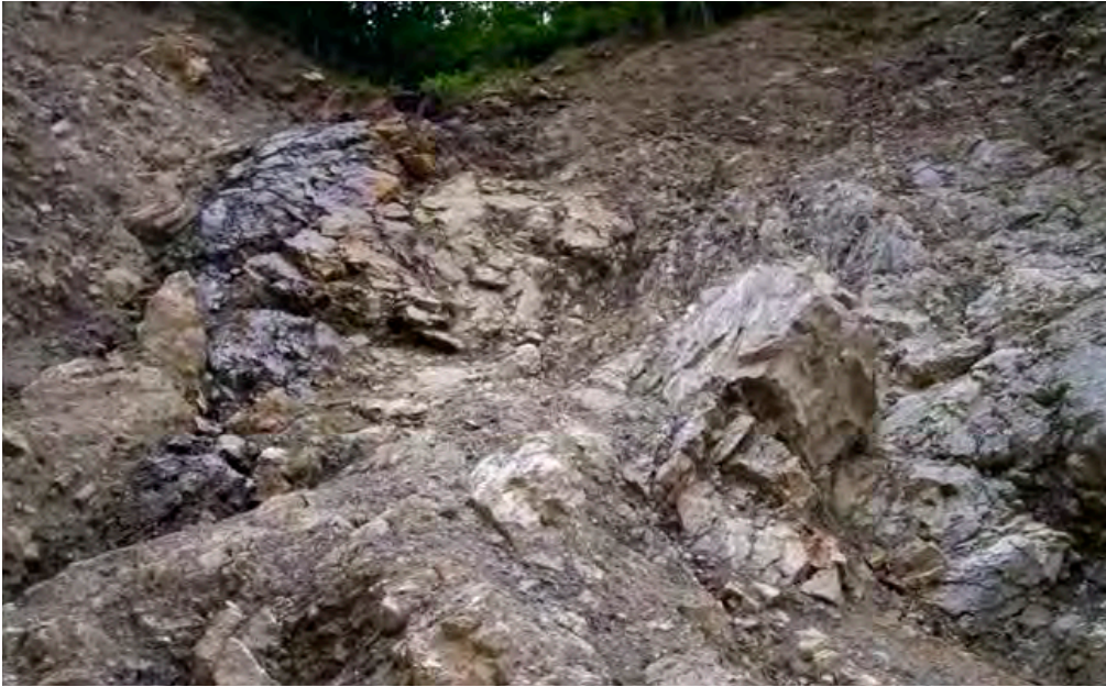
Fig. 4.5. Obsérvese como el agua infiltrada aflora a través de las fracturas en la vertiente izquierda del torrente San Jaime.
