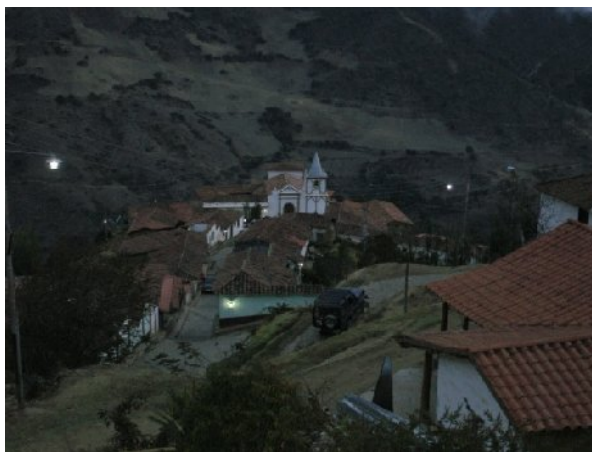
Foto N° 18: Sistema eléctrico en la comunidad de Los Nevados. De Manuel Rebaque, 2010
